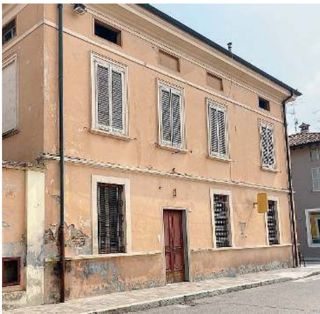
Il palazzo. Lo stabile che necessita di essere riqualificato
